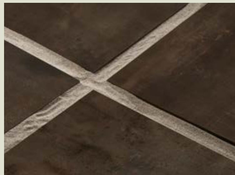
Posa a secco su sabbia Dry laying on sand Pose à sec sur le sable Trockene verlegung auf sand
