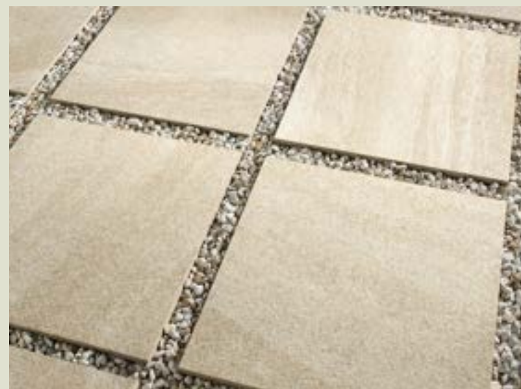
Posa a secco su ghiaia Dry laying on gravel Pose à sec sur le gravier Trockene verlegung auf kies
