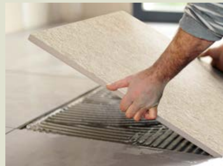
Posa a colla Laying with adhesives Pose collée Verlegung im kleberbett
