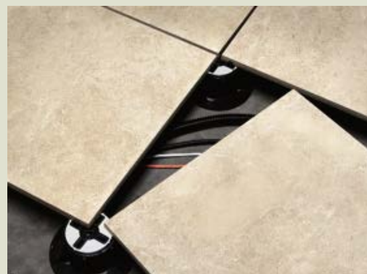
Posa rialzata per esterni Outdoor raised pavings Plancher surélevé extérieur Aufgestellte verlegung für aussenbereiche
